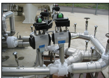
Valvole Adler attuate e manuali installate sull'impianto. Adler valves with pneumatic actuators and manual on the plant.
